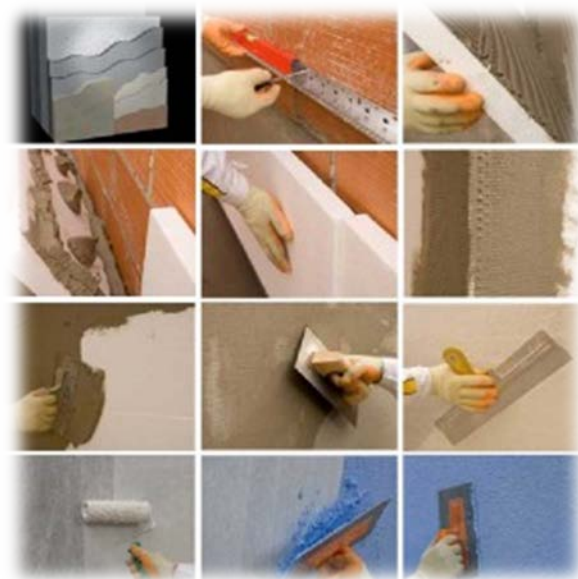
Aislamiento fachada con poliestireno expandido
